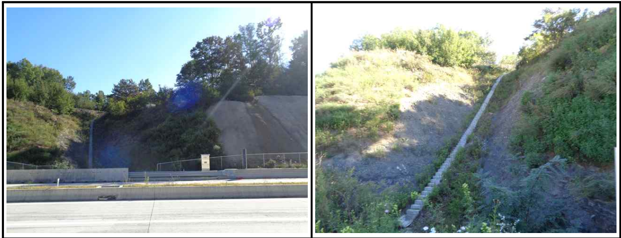
【그림 58.3.1】 상부자연사면 전경
