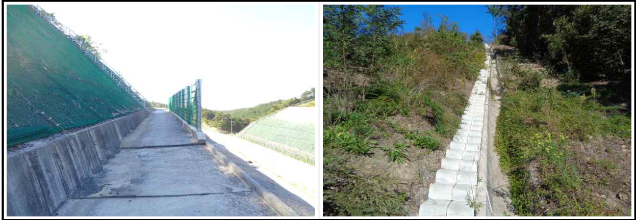
【그림 58.3.3】 배수시설 전경
